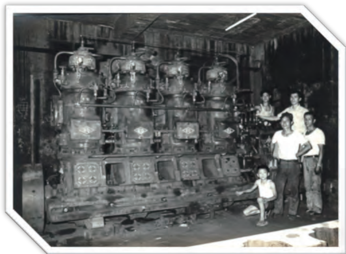
圖3、蘇澳鐵工廠生產之四汽缸燒頭式引擎(侯昭源先生提供)
