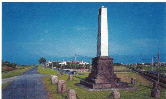
4-2 蘭陽溪治水工事
