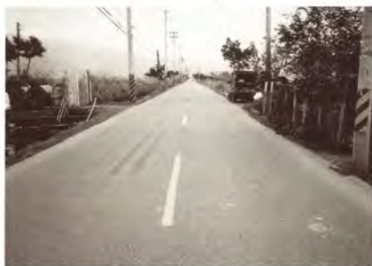
圖9. 191道路是日治時期的陸軍路，兩旁的水溝是當年挖土填路的結果。而目前的拓寬工程，則影響著未來發展。 張文義攝
