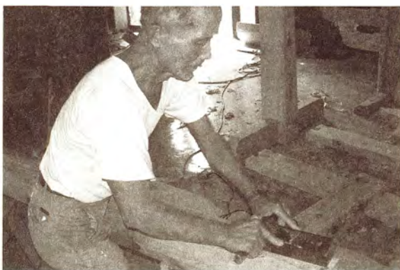
圖6.匠師以手刨細整構件表面。
