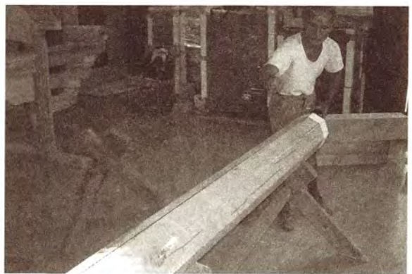
圖4. 匠師靈活的運用墨斗彈出弧形墨線在八角形長毛料上，以施作梭桁屋。
