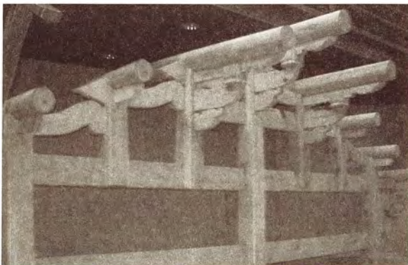
圖2.施作完成之穿斗大木架。
